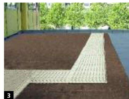
3 Verlegen der Drainage- und Wasserspeicherelemente als thermo-mechanischen Schutz.
