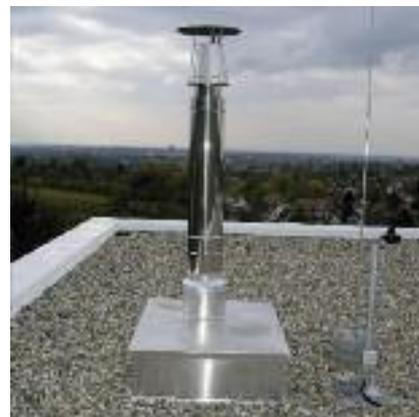
1 Verarbeitungsdetails, Kompaktdach 25®, Randverwahrung mit Metall und Dachdurchdringung in Edelstahl.
