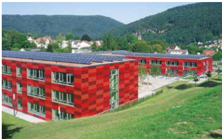
Photovoltaik-Dächer Schulzentrum Neckargemünd, Deutschland
