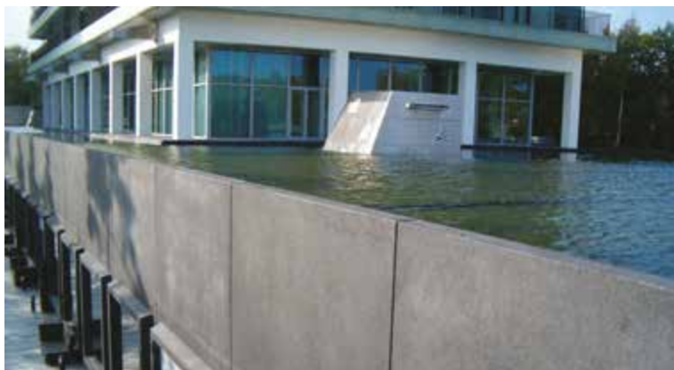
Retentionsdächer Walterbos Complex, Apeldoorn, Niederlande
